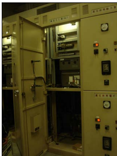
20年度 受変電設備改修（コンデンサ類）
