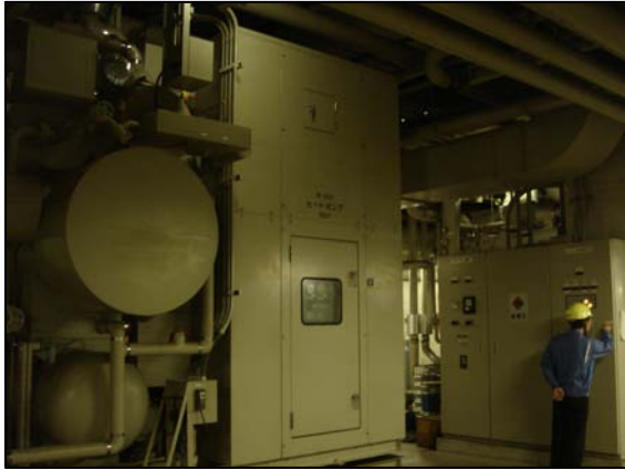
20年度 冷凍機オーバーホール
